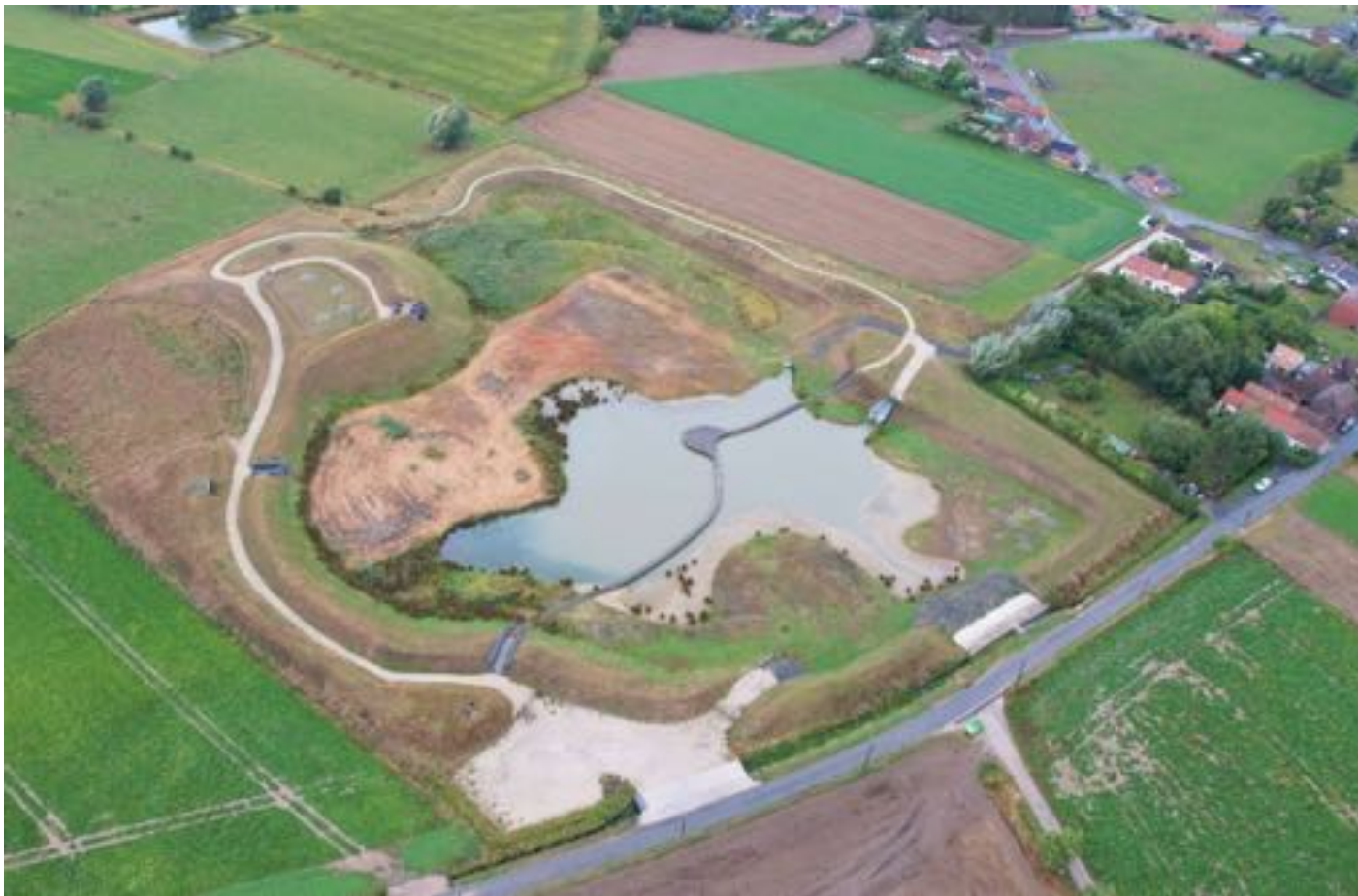
Deux zones d'immersion temporaire (ZIT) à Willemeu, Tournai. Zones d'immersion temporaire éco-intégrées de Willemeu. Source: Référentiel Constructions et aménagements en zone inondable, 2022, SPW. Crédit photo : publica-brussels.com
