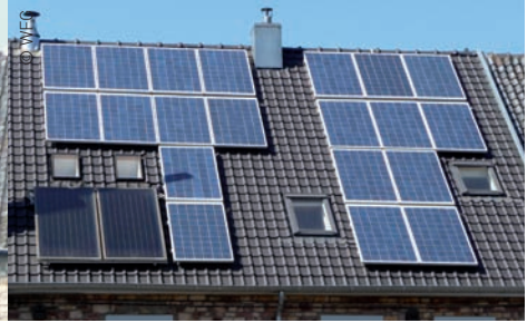
Zusätzliche Unruhe durch Zerstückelung der Photovoltaikfläche
