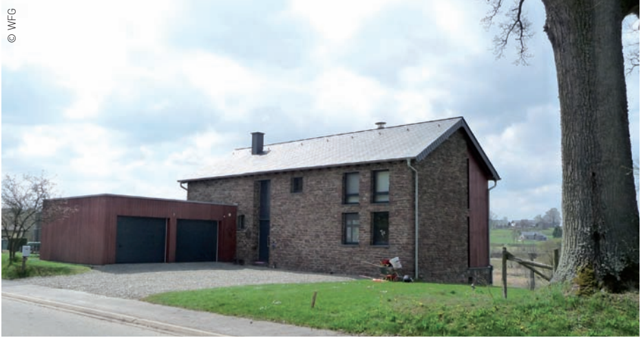
Spannung zwischen offenen und geschlossenen Fassadenbereichen. Die Öffnungen ordnen sich der Fassade unter
