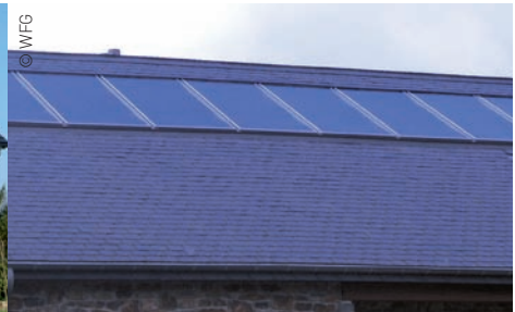
Zusätzliche Unruhe durch Zerstückelung der Photovoltaikfläche
