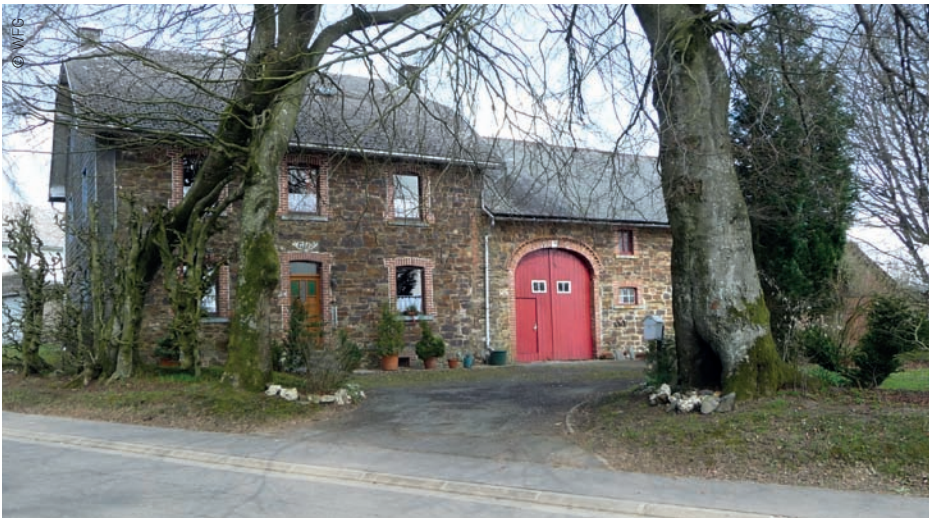
Hier prägen die Bäume das Gebäude
