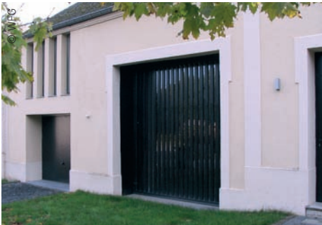
Die Öffnung des ehemaligen Scheunentores wird nun als zusätzliche Lichtquelle genutzt
