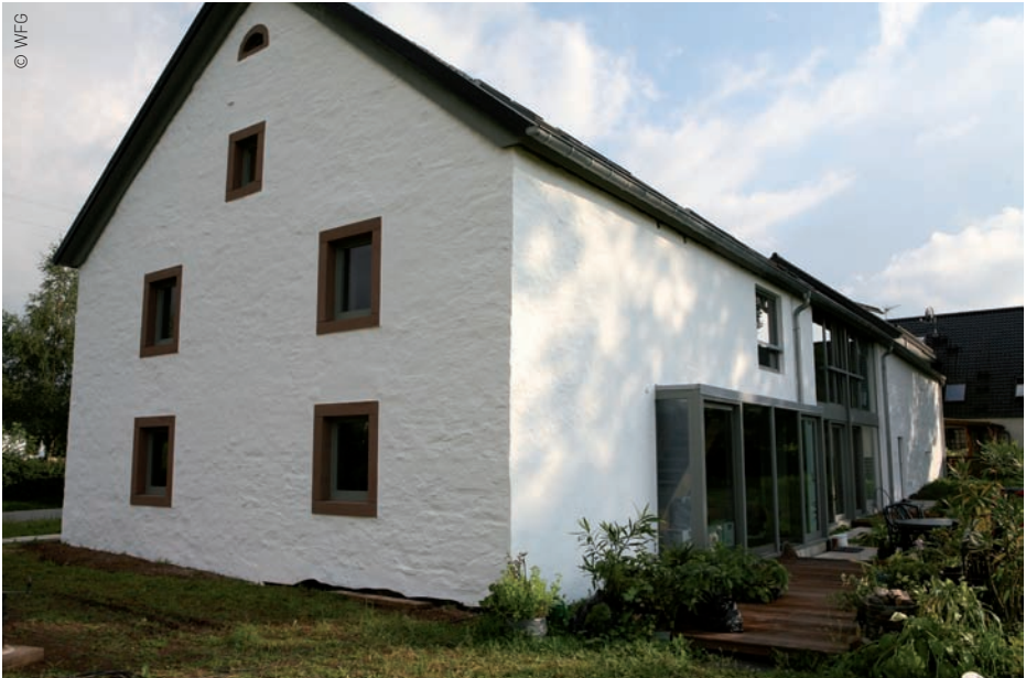
Die Gruppierung der neuen Fensteröffnungen lässt die Geschlossenheit der vorher fast fensterlosen Fassade spüren
