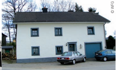
Heute: Verändertes Volumen und abgeändertes Dach. Der größere Dachüberstand dominiert den Baukörper und verändert das Bild des Hauses
