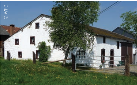
Ein schönes Beispiel eines Breitgiebelhauses
