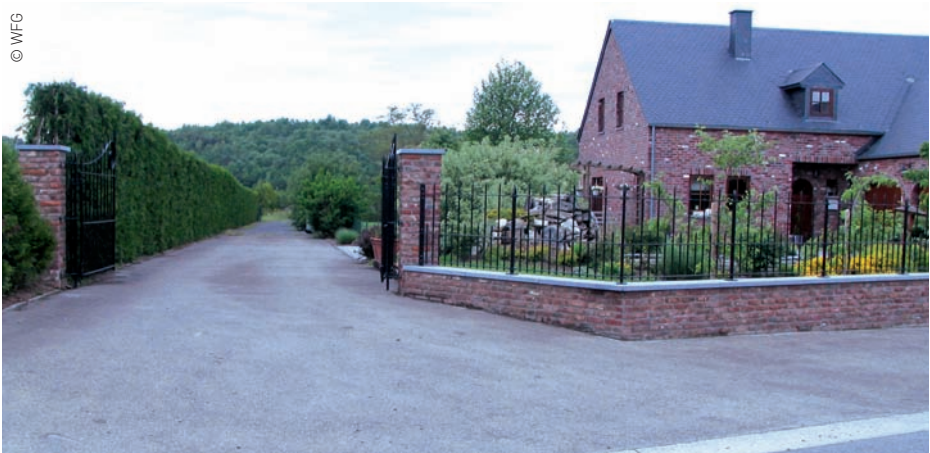
Treppen, Stützmauern, Hecke oder Zaun trennen den Vorgarten von der Straße
