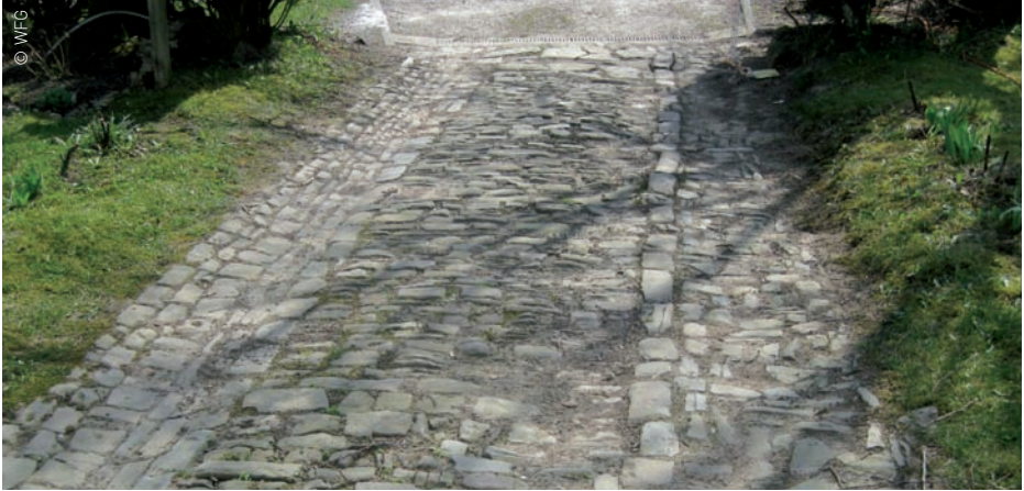
Erhalt einer alten Natursteinpflasterung
