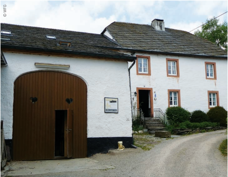
Die Bauten fügen sich ins vorhandene Relief ein
