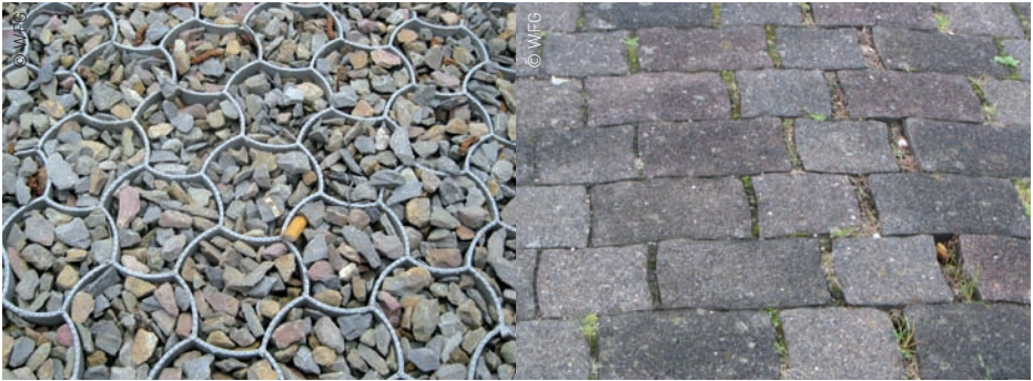
Kunststoffrasengitter mit Schotter gefüllt
