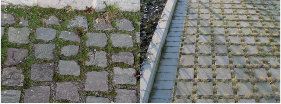
Pflasterung mit grüner Fuge
