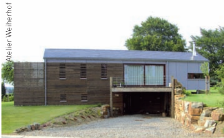
Moderne Gebäude ohne Dachüberstand
