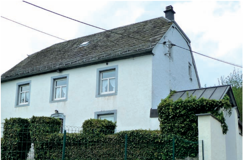
Beispiel eines gelungenen Zinkdaches an einem Gebäude mit altem Schieferdach
