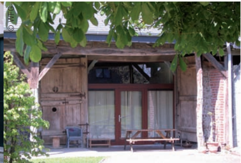
Die alten Holzschläge des Scheunentores bleiben erhalten und werden durch eine moderne Verglasung ergänzt
