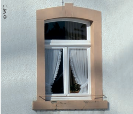
© WFG Neues T-Fenster aus Holz mit guten Proportionen. Auch die feine Profilierung ist sehr gut ausgeführt
