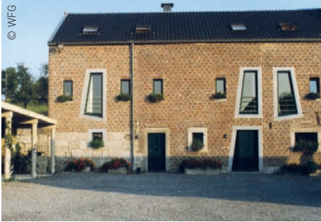
Bei diesem Umbau fallen die eigenwilligen Fensterformate der Scheune auf. Alte und neue Öffnungen sind unterschiedlich ablesbar
