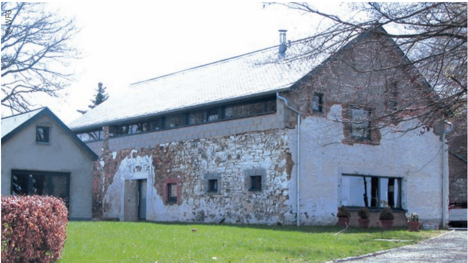
Belichtung durch ein Lichtband (Gebäude noch im Umbau)
