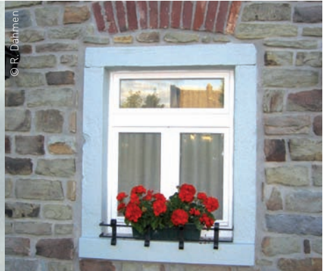
© R. Dähmen Neues T-Fenster mit einer überbreiten und flächenbündigen T-Aufteilung. Die Verglasung des Oberlichtes wird dadurch zu schmal
