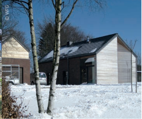
Die Fassade wird durch das Material gegliedert
