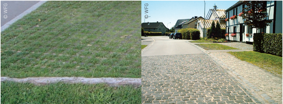
Rasengitter – wenig befahren sind die Gitter nicht sichtbar
