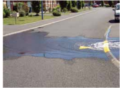
Chaussée à structure réservoir
