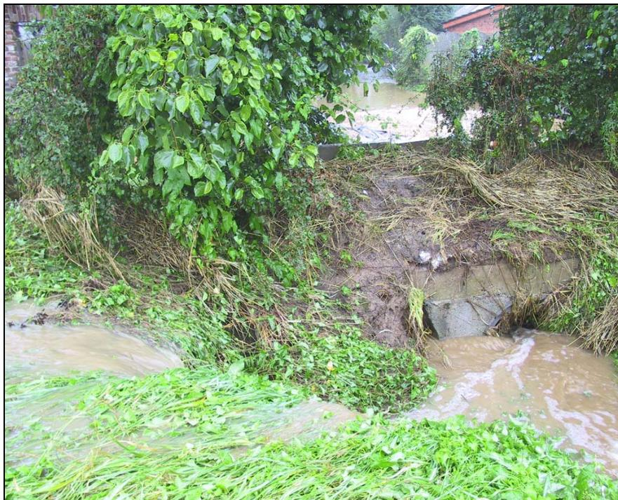
**Figure 12. Tête de cours d'eau voûtée, sans sécurité de déverse pour les pluies exceptionnelles, outre les diminutions de capacité du conduit pour diverses raisons, l'encrassement par boues et pailles, collecteurs supplémentaires raccordés, etc.) : les eaux de ruissellement n'ont d'autre possibilité que de passer en surface, traversant habitations et voiries**
