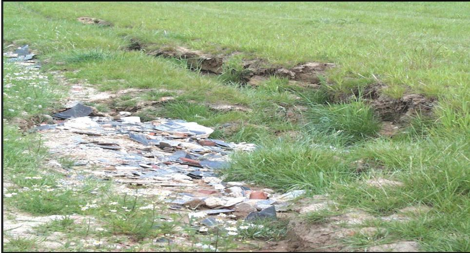
**Figure 9. Le chemin a été rehaussé et rejette les eaux vers la bande enherbée...- D'autres cas relativement fréquents portent sur des voiries plus importantes qui, rehaussées lors d'un asphaltage ou autre, rejettent localement et brutalement les eaux de ruissellement vers des habitations**
