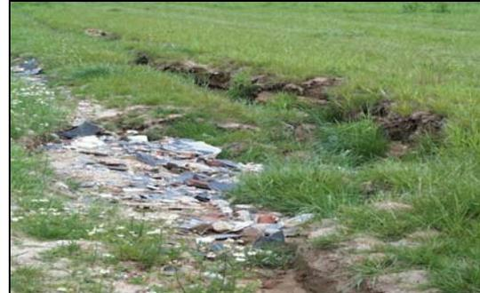
**Figure 10. Route rehaussée et fossé comblé : nouvelle ravine se développant dans la bande enherbée (Photo Dautrebande S., 1999)**
