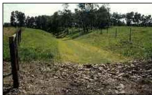
**Figure 13. Aménagement d'un chenal à base empierrée et enherbée (USA)**
