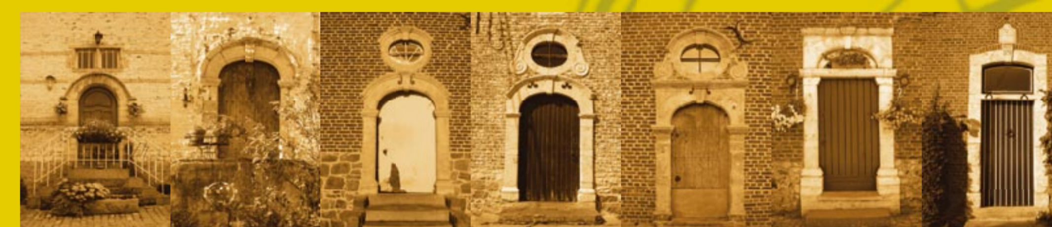
Évolution théorique du tour de porte en pierre de Gobertange, du milieu du XVII e s. à la fin du XVIII e s. : ferme de la Tilleraie à Bonval (mi XVII e s.), ferme du Grand Haquedou à Roux-Miroir (vers 1660), cense Sery à Orlon (vers 1717), ferme Saint-Jean l'Évangéliste à Petit-Rosière (vers 1730), ferme à Mont-Saint-André (1733), ferme à Pottreain (1731), ferme à Noddinge (1789).
