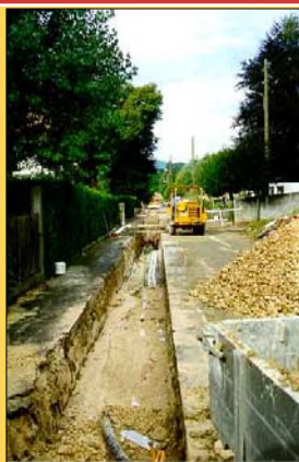
Réseau principal en voirie
