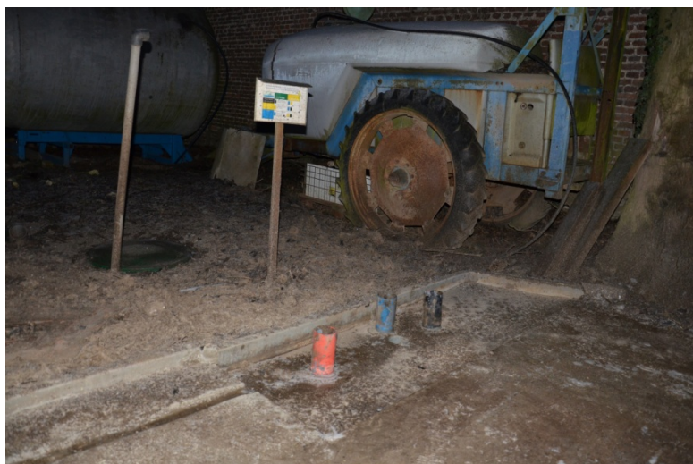
Figure 4. Aire de lavage et remplissage : système de gestion des écoulements avec 3 sorties indépendantes.
